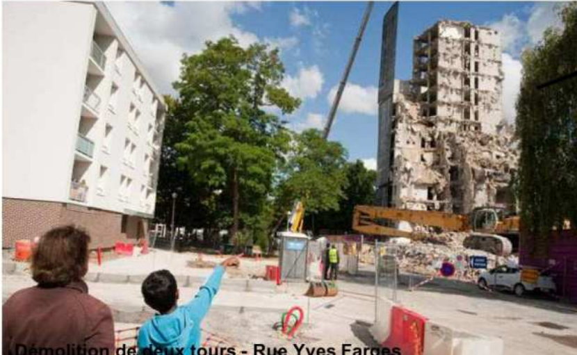
Démolition de deux tours - Rue Yves Farges
