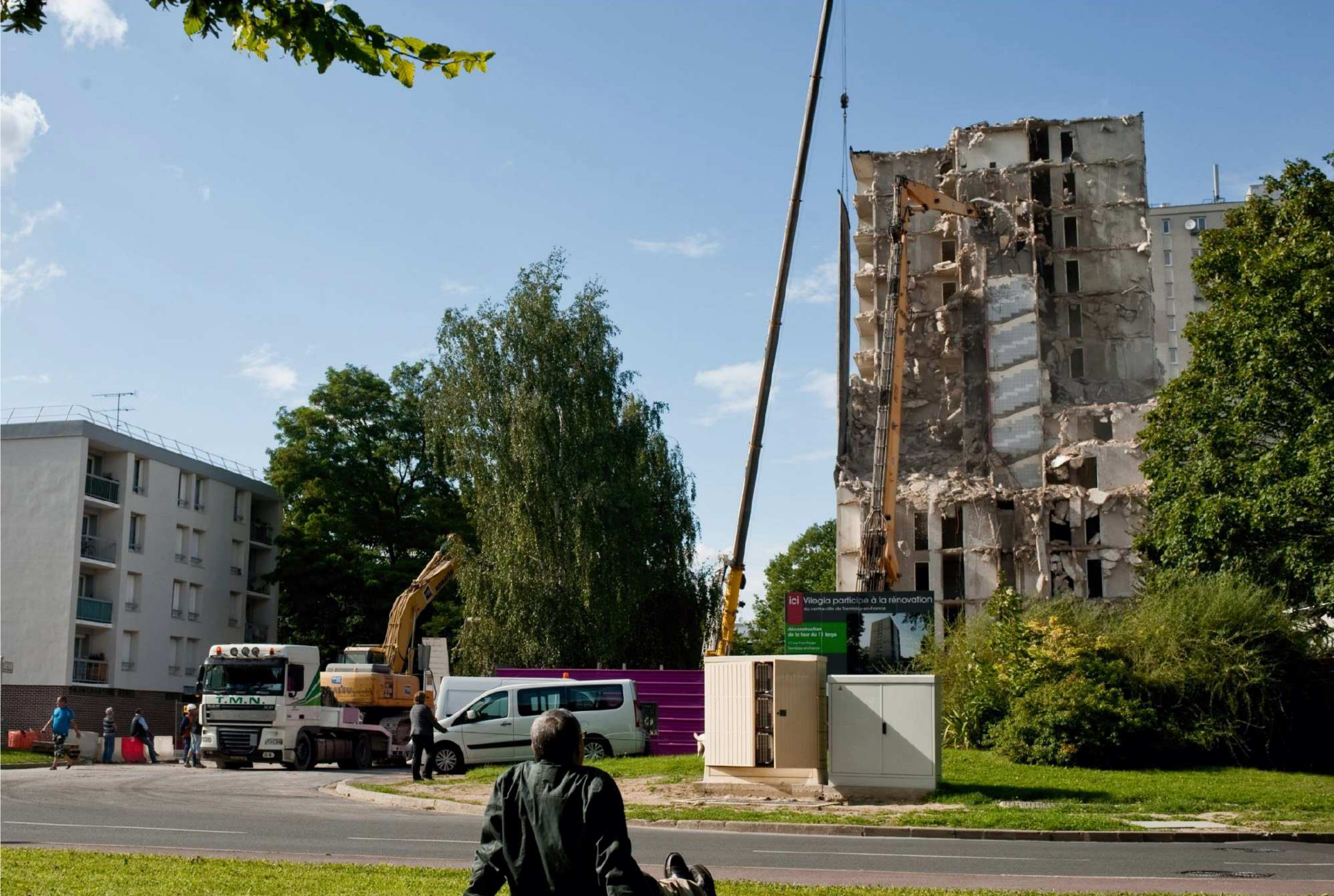
Démolition de la tour « 11 Farge »
